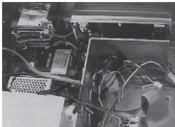
写真4 高圧高速インパルス電圧発生ユニット
